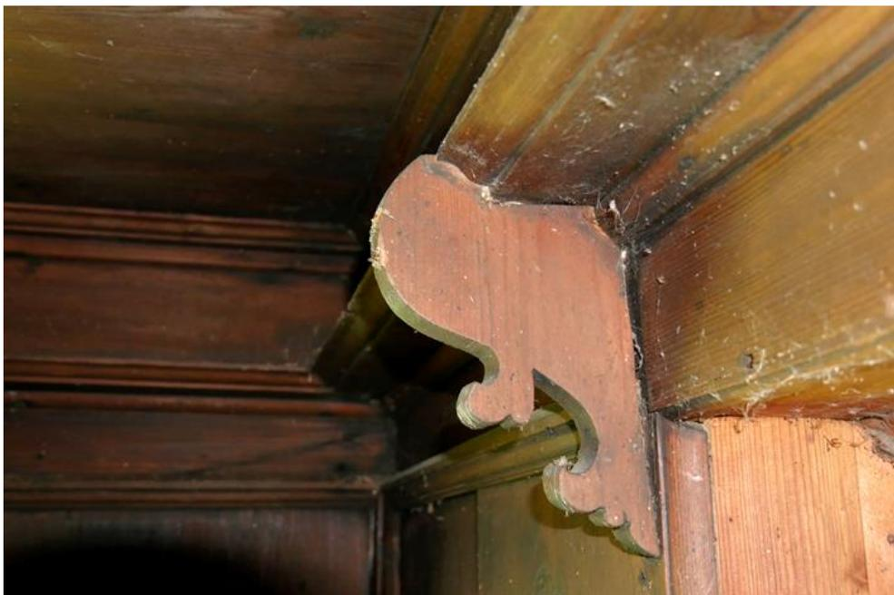
Abbildung ST2 Vollständige Konsolle ohne Schaden R1.05 Wand B
