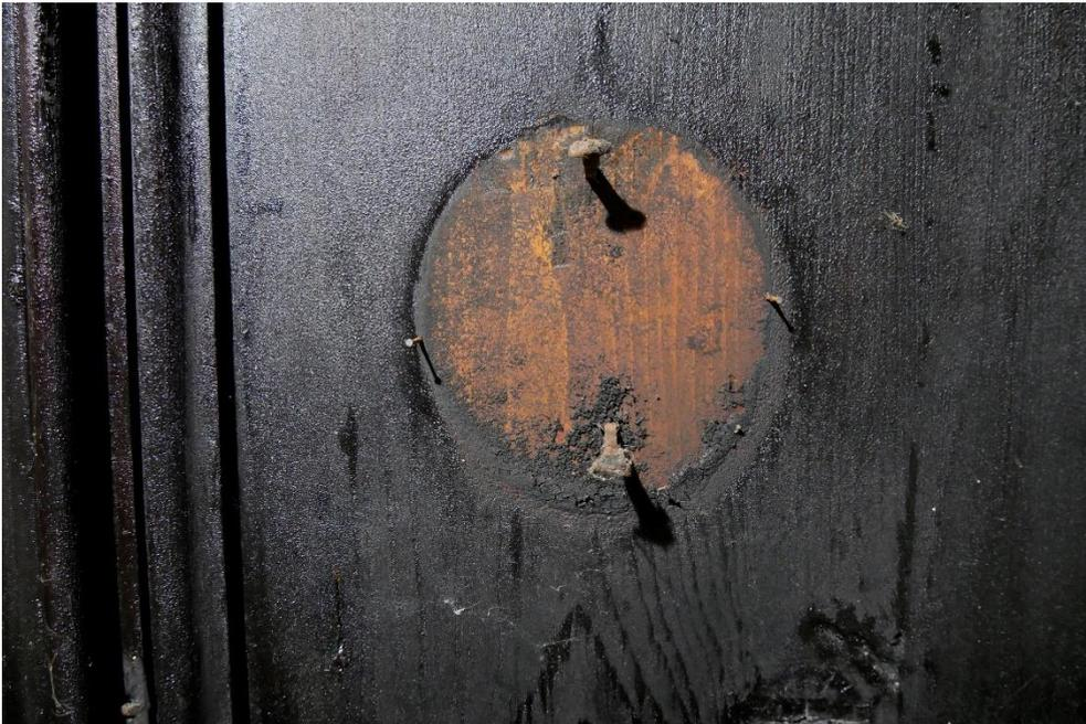
Abbildung ST17 Abdruck einer Rosette: über dem Ofen war vermutlich ein Gestänge zum Trocknen von nassen Kleidern angebracht, das an der Decke verankert war. Darunter ist der Lack nicht verschwärzt.
