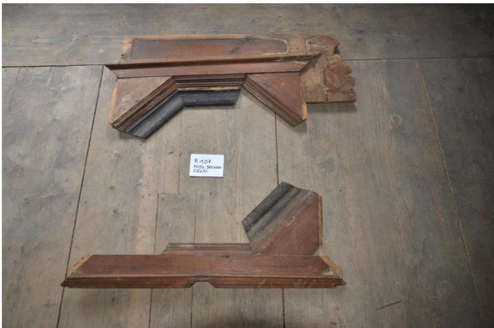
Abbildung ST33 Teile des Mittefeldes der Decke im Raum 1.07
