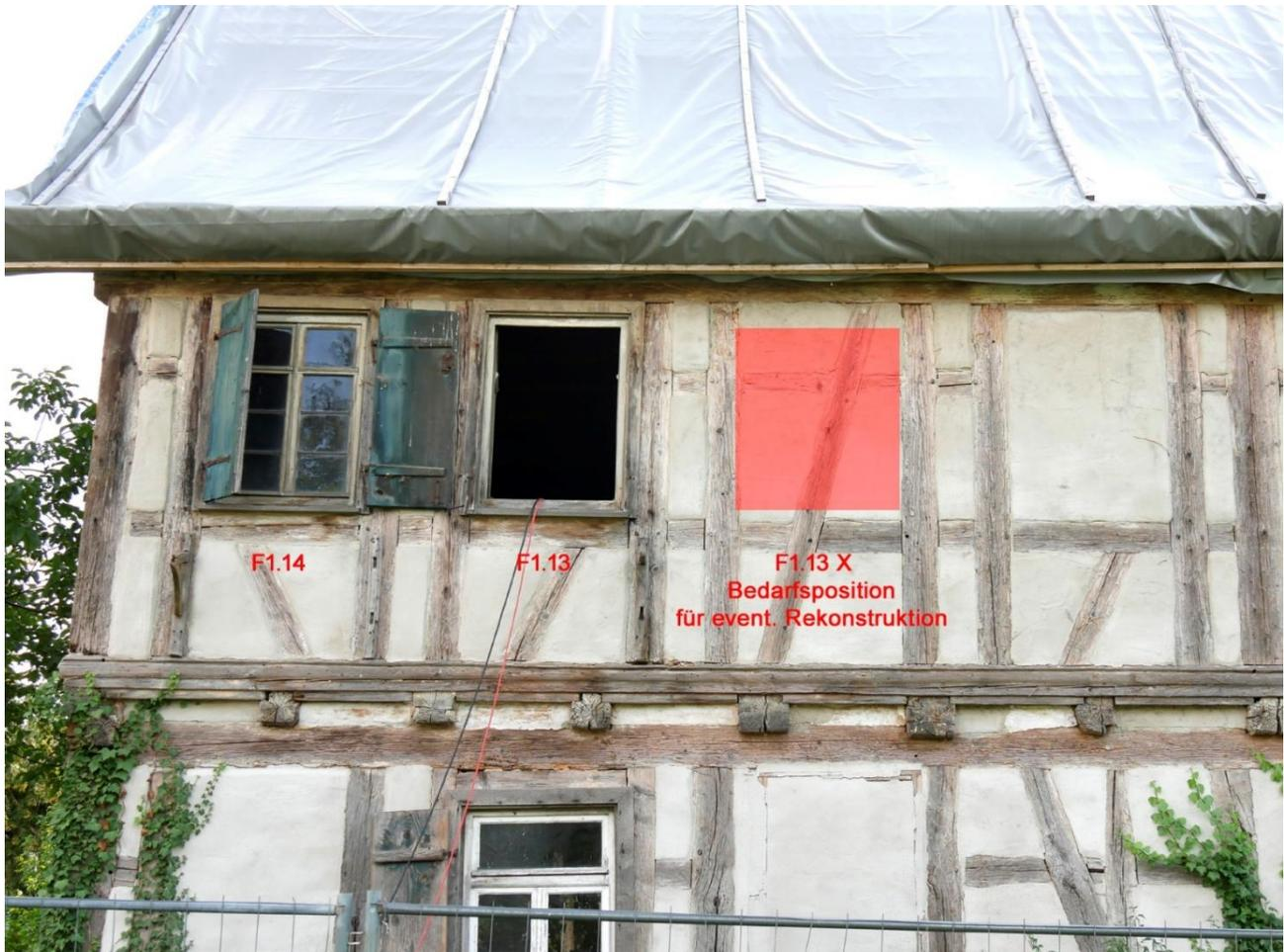
Abbildung F8 Fenster F1.13 im Raum 1.0 Position eines zugemauerten (?) Fensters für eine Bedarfsposition zur Rekonstruktion
