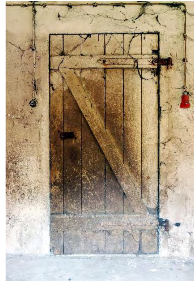
Abbildung T11 Stalltür zwischen den beiden Ställen
