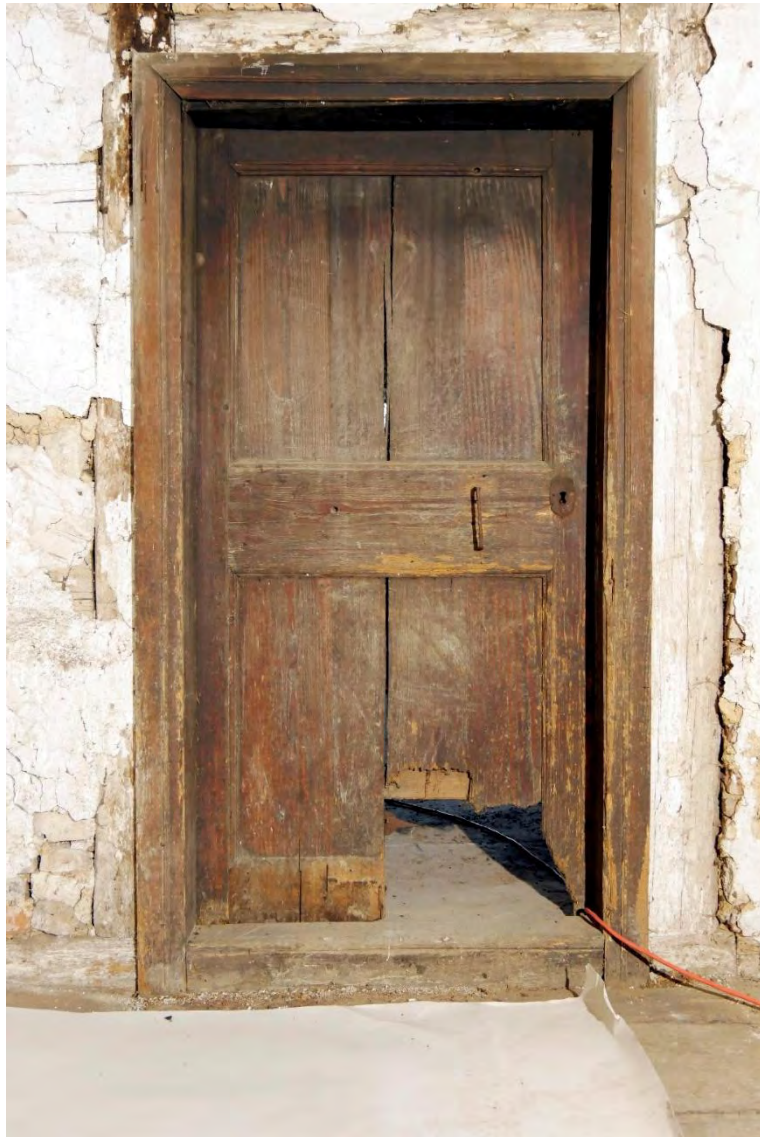
Abbildung T1 Tür zur Küche T1.03 Ansicht vom Treppenflur
