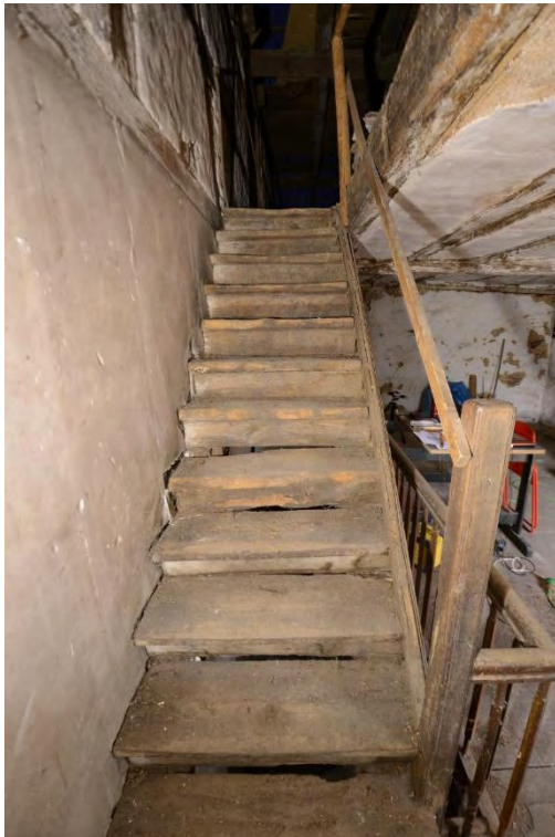
Abbildung T1 Blockstufentreppe vom Obergeschoss zum 1.Dachgeschoss
