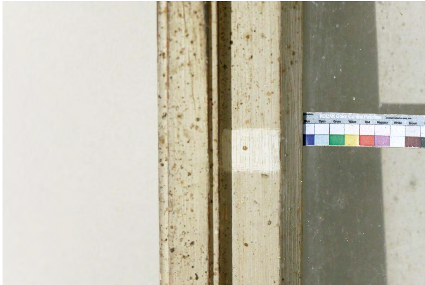
Abbildung F7 Fenster F1.13 im Raum 1.05 Gereinigte Lackfläche
