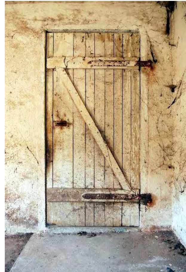
Abbildung T1 Stalltür zwischen den beiden Ställen Stallseite
