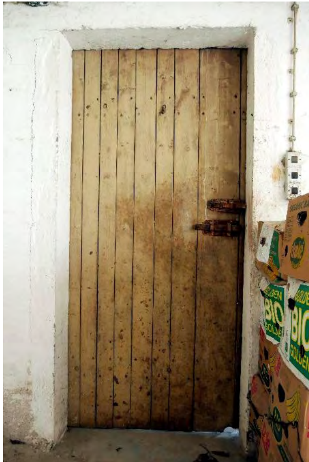
Abbildung T11 Stalltür zwischen den beiden Ställen Wohnhaus-Seite
