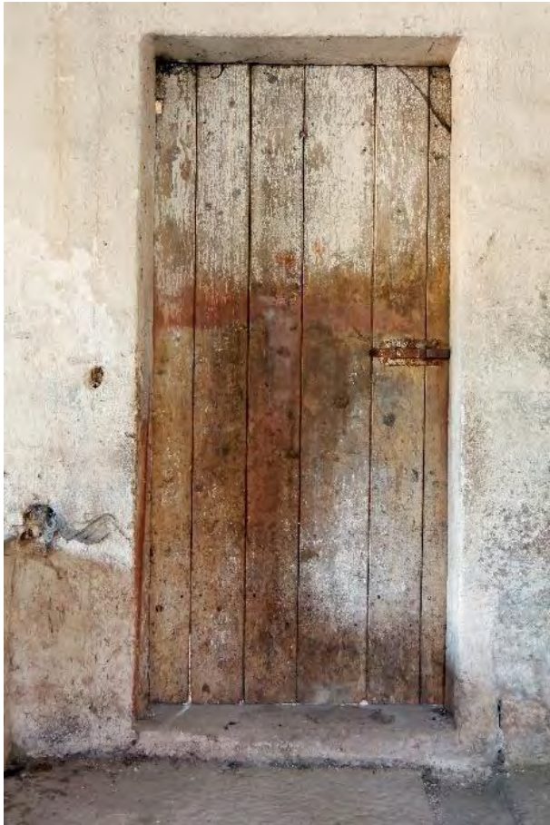
Abbildung T11 Stalltür zwischen den beiden Ställen Dorfseite
