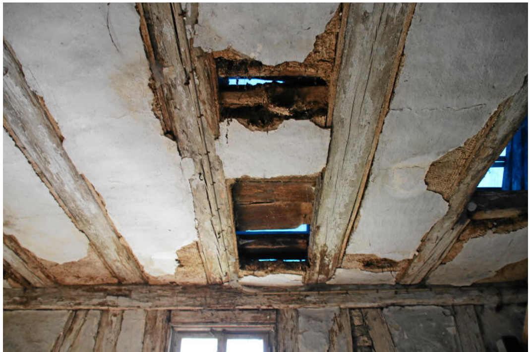
Abb. 19: Herabgefallene Deckenfüllungen.
