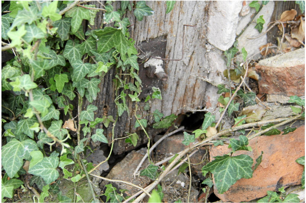
Abb. 13: Fehlende Schwelle.
