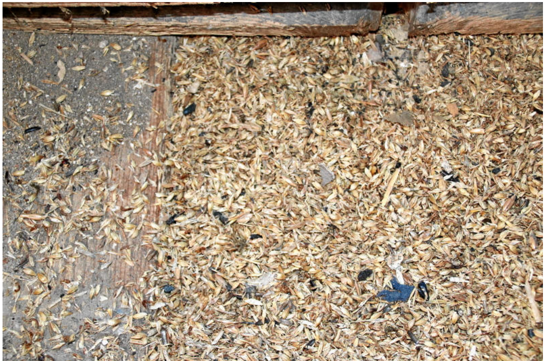
Abb. 37: Besatz von Mehlkäfern in den Balkengefachen.
