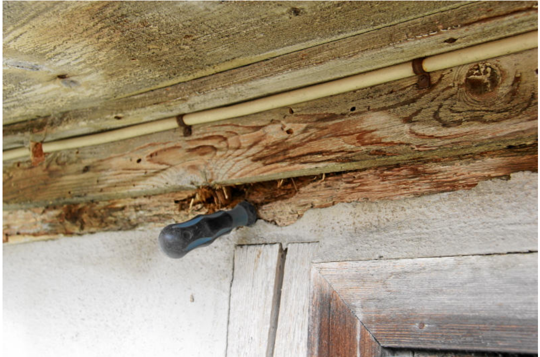
Abb. 07: Pilzgeschädigtes Wandrähm.
