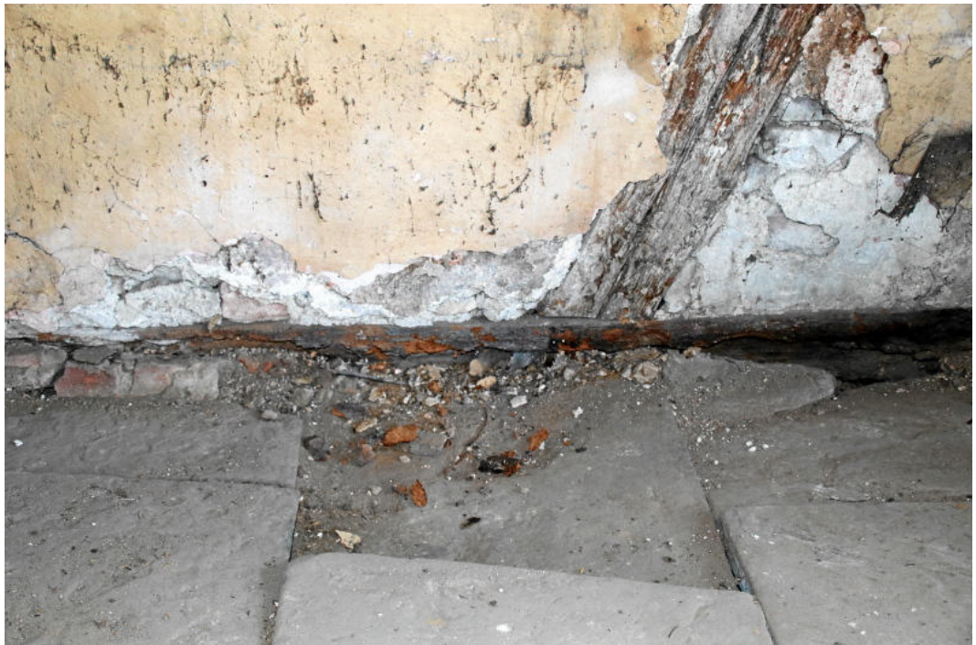
Abb. 24: Teilgeschädigtes Fachwerk.
