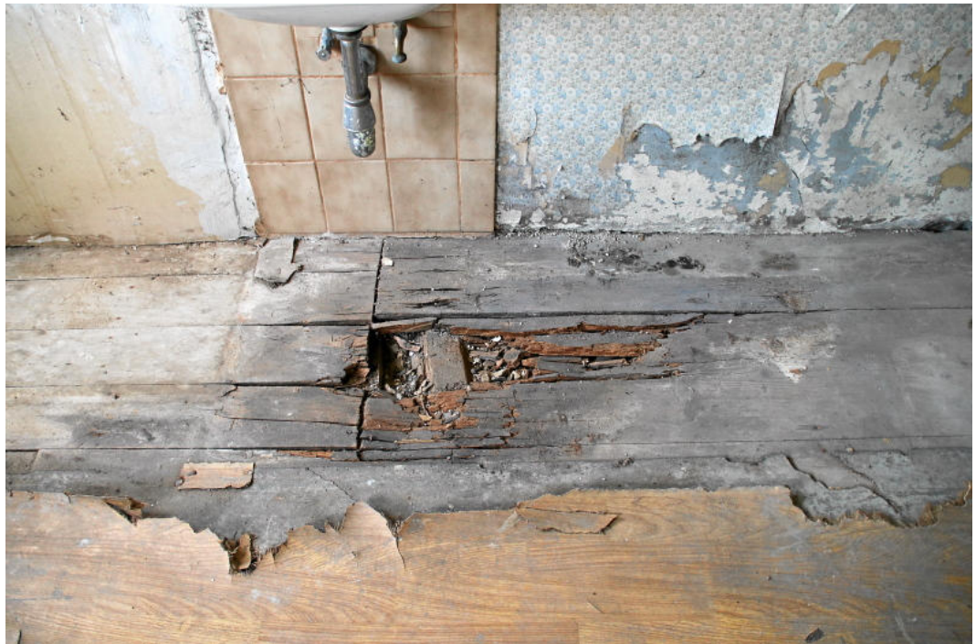
Abb. 17: Pilzgeschädigter Bodenaufbau.
