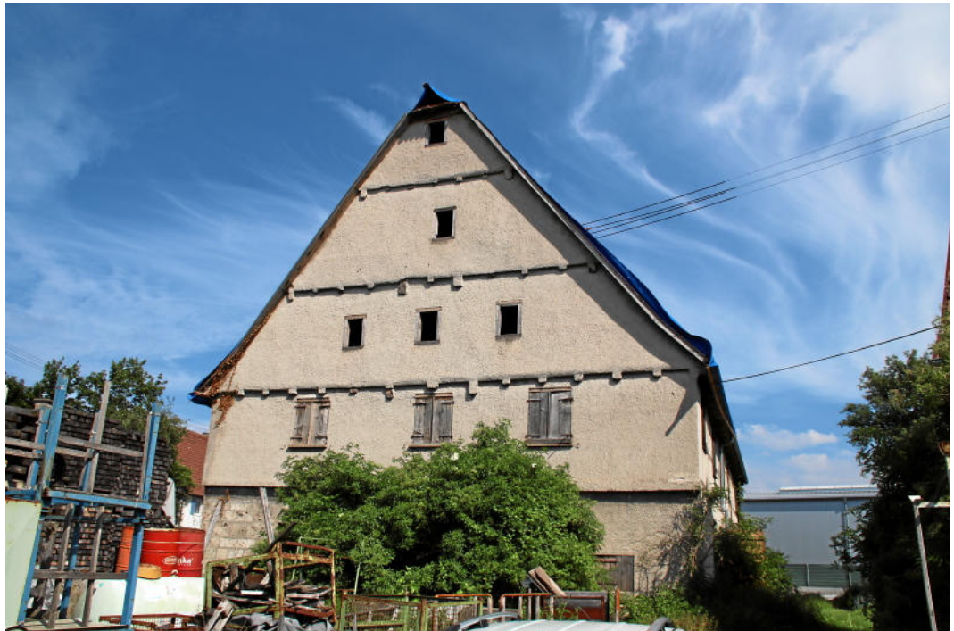
Abb. 08: Verputzter rückwärtiger Fachwerkgiebel.
