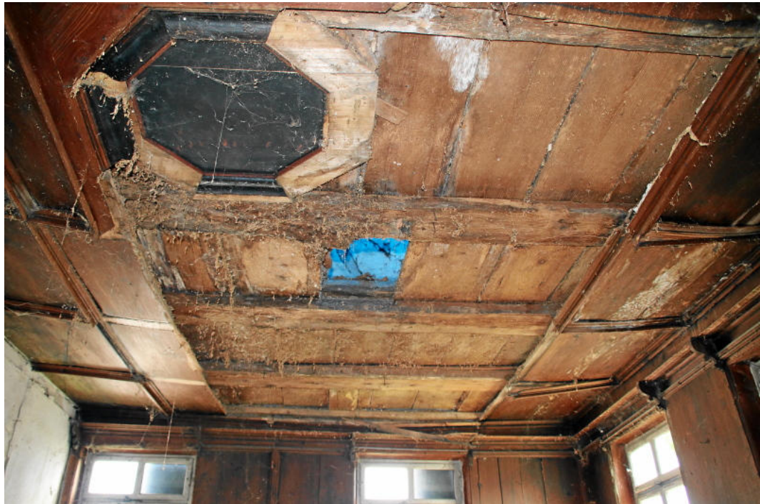
Abb. 27: Abgenommene bzw. herabgefallene Deckenbekleidung.
