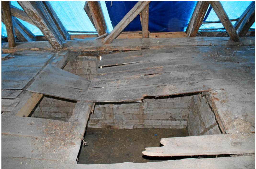
Abb. 30: Schadhafter Deckenbereich.
