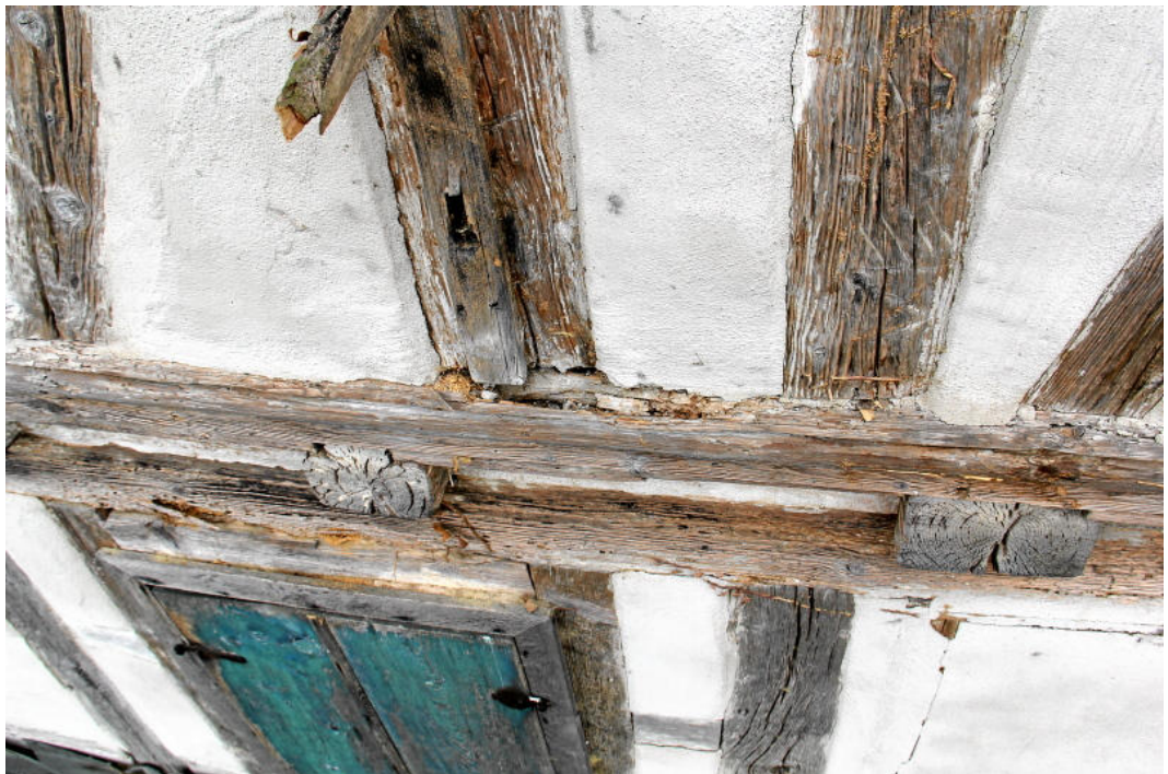
Abb. 14: Schadhafte Schwelle.
