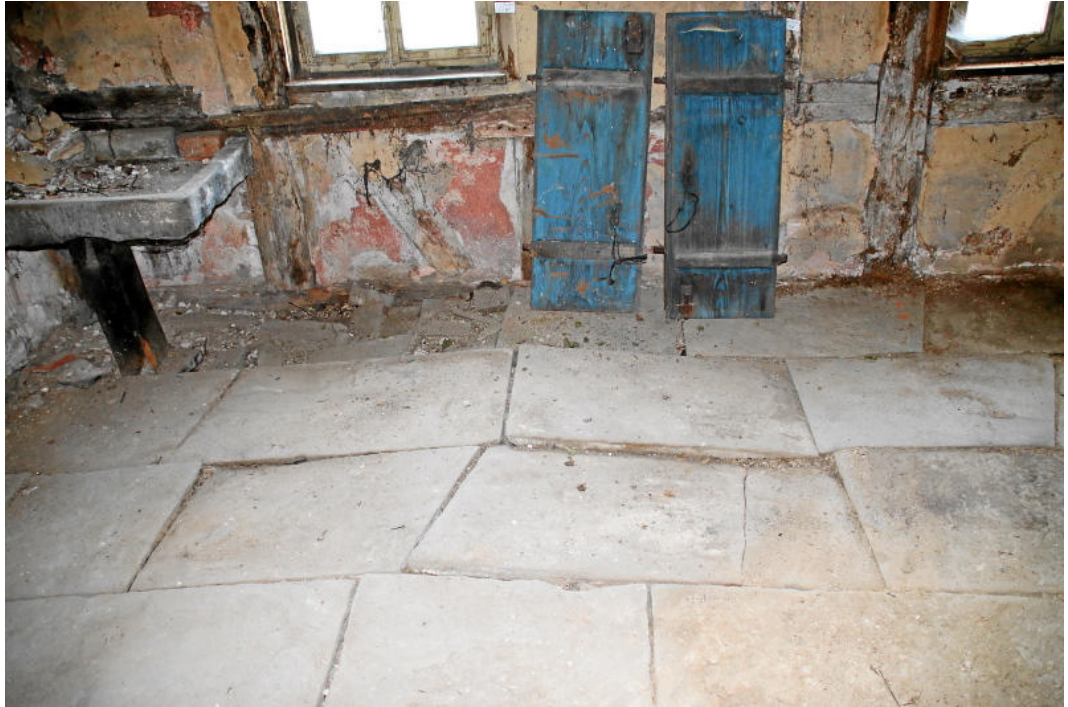
Abb. 25: Verformte Decke.
