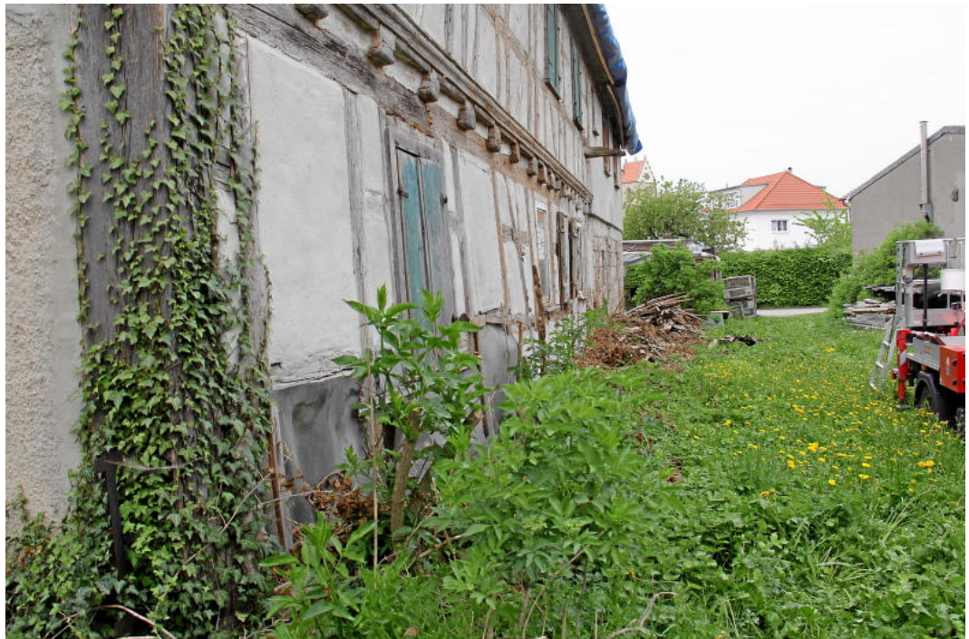
Abb. 12: Geländeanschluss zur Fachwerkwand.
