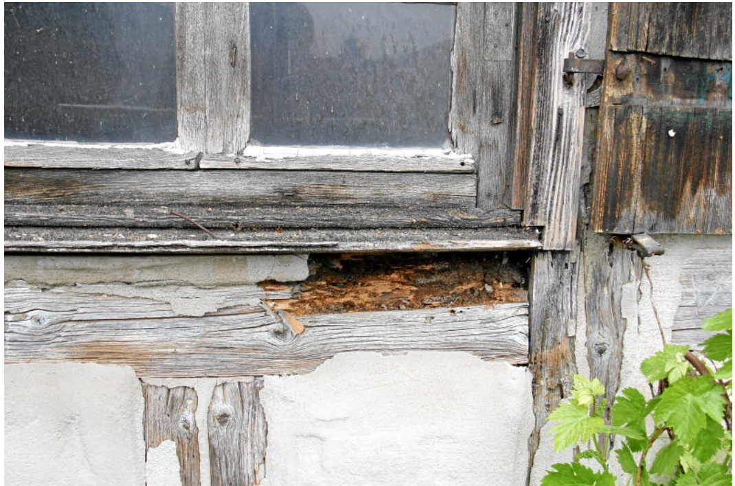
Abb. 04: Schadhafter Brüstungsriegel.
