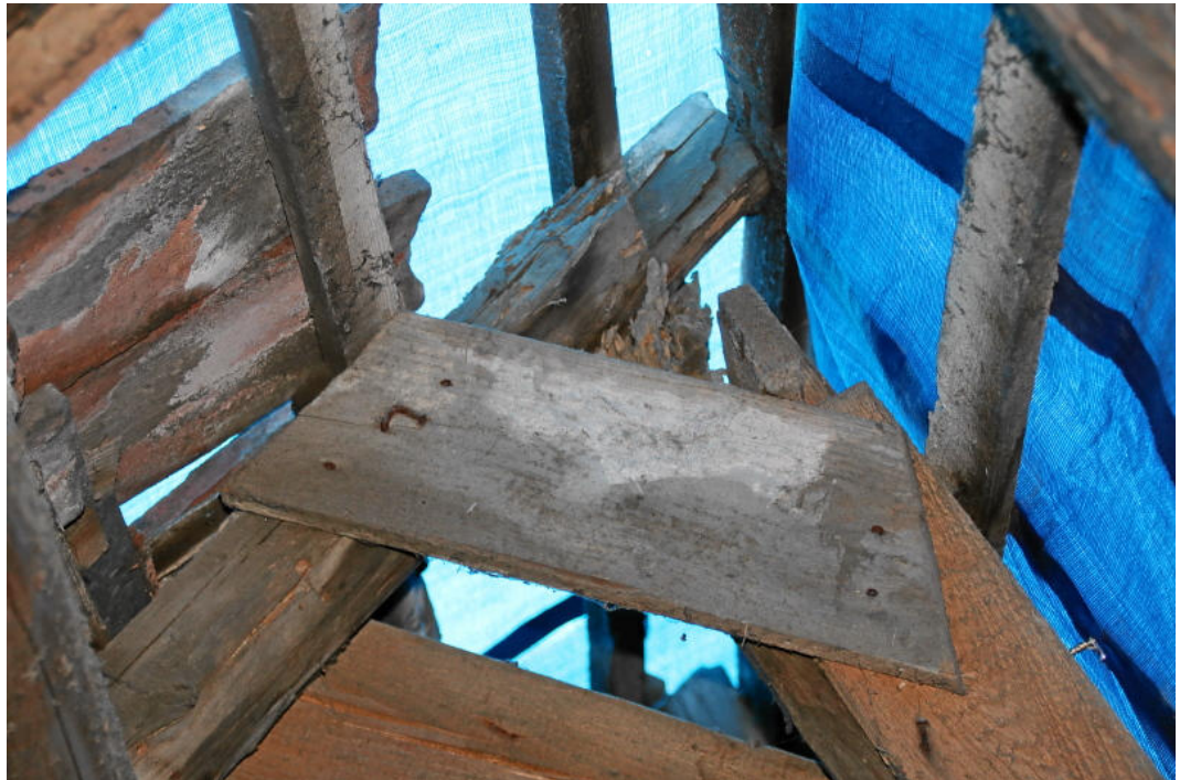
Abb. 34: Schadhafter Sparrenfirstpunkt.
